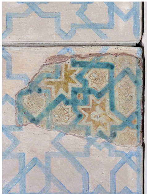
Imagen: Muestra de azulejo de lacería restaurado. Fuente: Patronato de la Alhambra
